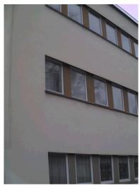
Die Fassade zeigt die typischen Charakteristika einer nicht nach außen gedämmten Wand auf. Es zeichnen sich einzelne Ziegel- und Mörtelfugen, Wärmebrücken durch die Einbindung der Geschossdecken und ein erhöhter Wärmeverlust im Bereich der Heizkörper ab.
