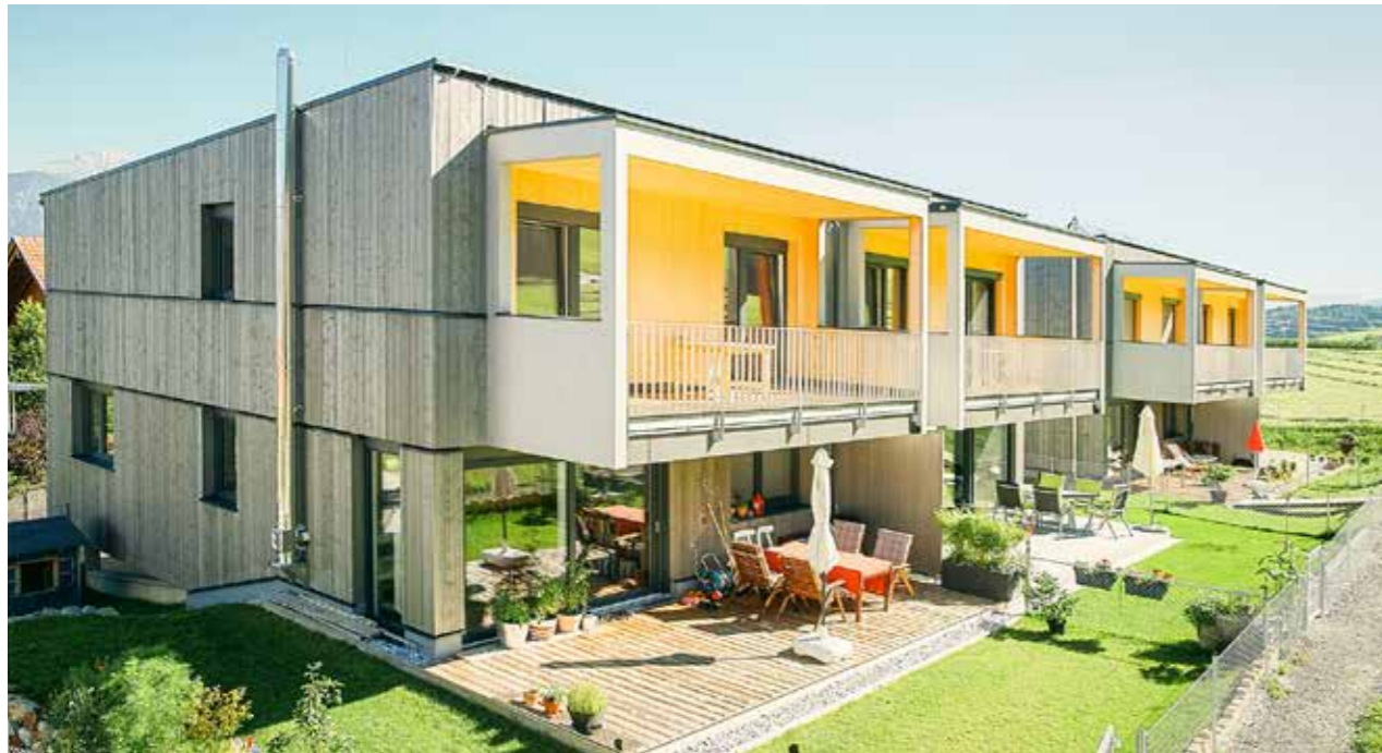
Moderne Holzbauweise in Sistrans.
